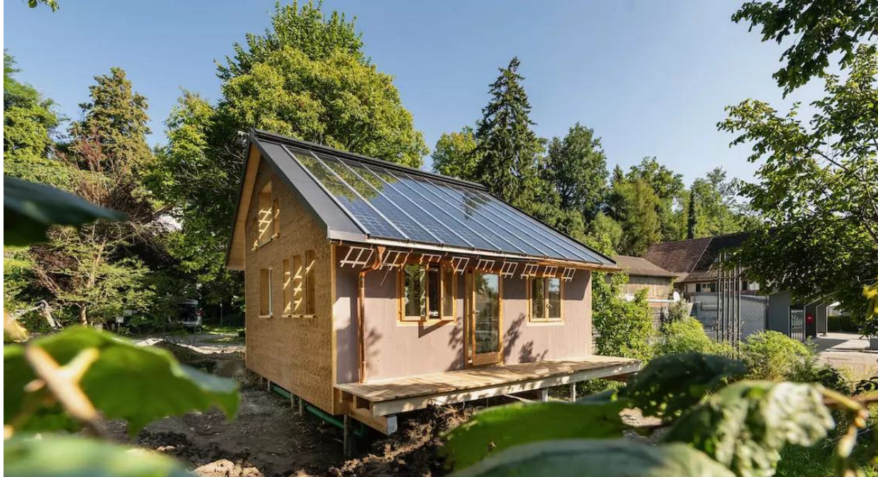
Abbildung 1: Aussenansicht vom KREIS-Haus [Quelle: ZHAW]
